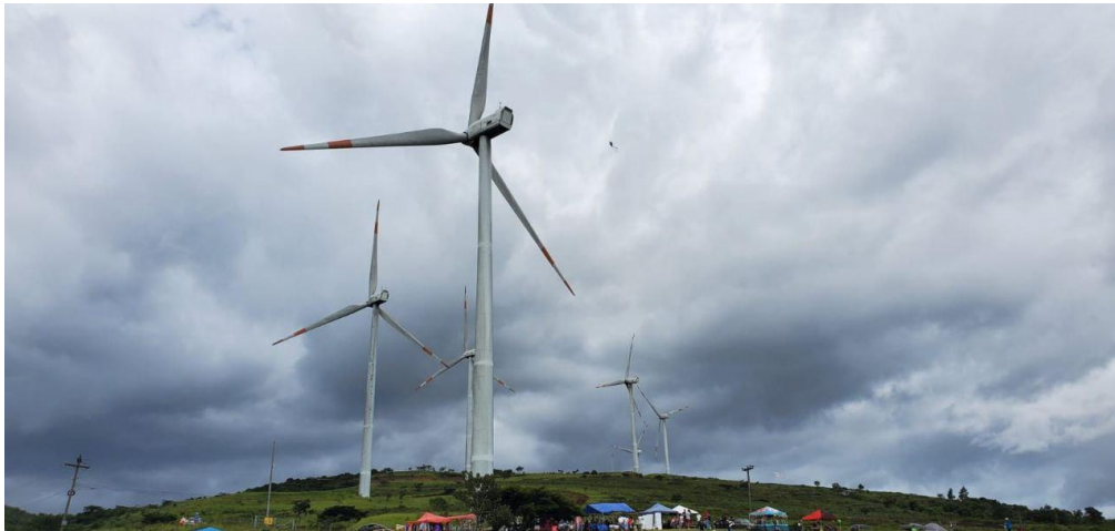
Figura 1. Parque Eólico Cerro de Hula
